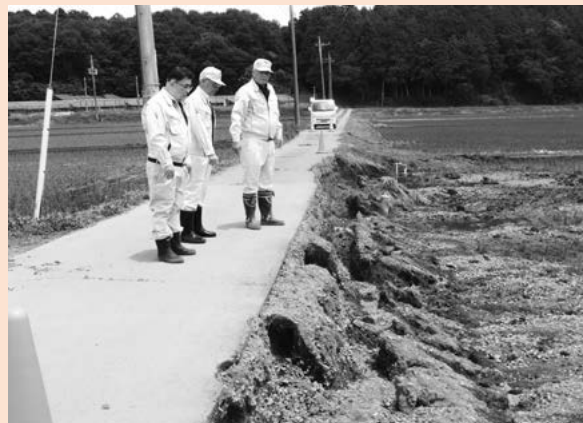
▲現地調査の様子 外之内地内
