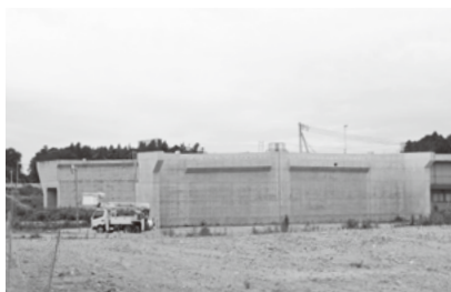
▲一般国道6号千代田石岡バイパス建設地（栗又四ヶ地内）
