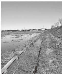
▶堤脚水路（令和4年10月20日撮影）
