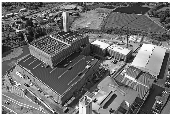
新ごみ処理施設整備事業（高崎地内）
