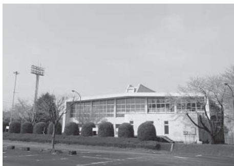
野球場・テニスコート・体育館等を有する総合運動施設。平成 20 年度における延べ利用者数は約 1 万 7,000 人 (小川運動公園・与沢地内)
