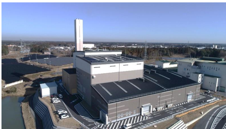
写真 クリーンセンターみらい
