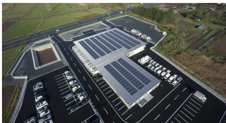
笠間太陽光発電所（笠間センター）
