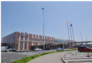
ターミナルビル外観
