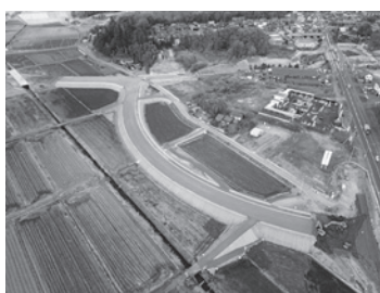
▲進むアクセス道路工事
