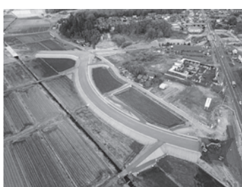
▲進むアクセス道路工事
