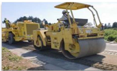
道路補修工事
