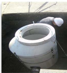
マンホール設置工事の様子
