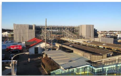
工事中のJ R羽鳥駅
