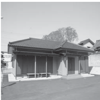
基地等の設置に伴う周辺住民への影響に配慮するため、再編交付金により整備される地区公民館（南原公民館）
