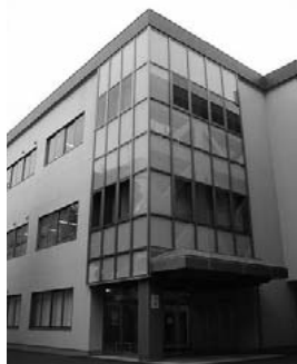
裁判員裁判棟の外観
