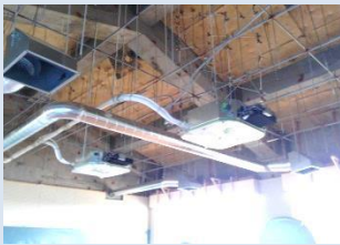
エアコン設置
