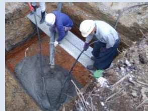
増築予定場所のコンクリート打設
